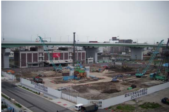
新名古屋校舎工事現場の様子
